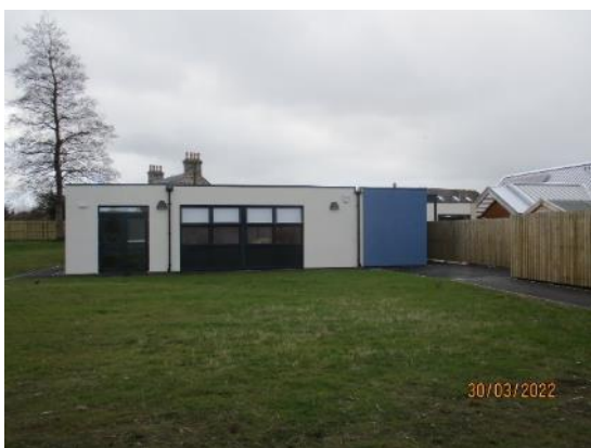
23. Annexe external walls
