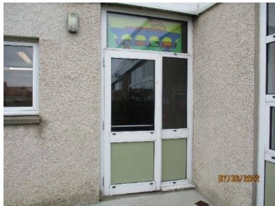
22. Fire escape door
