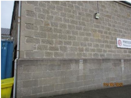
27. Natural stone walls
