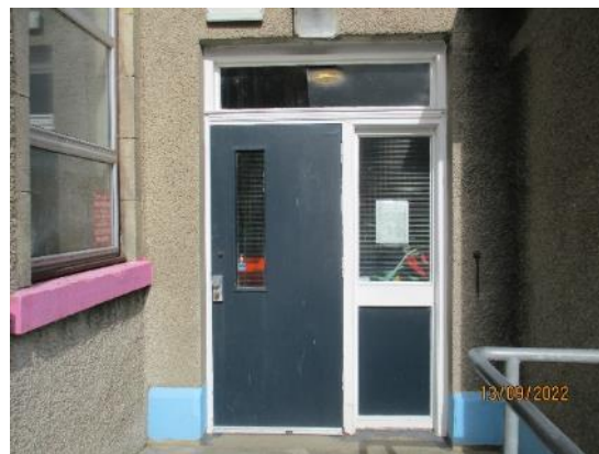
60. Door to Girls Toilet
