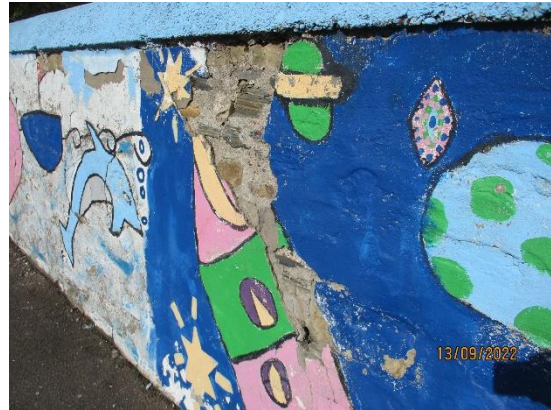
277. Render spalling
