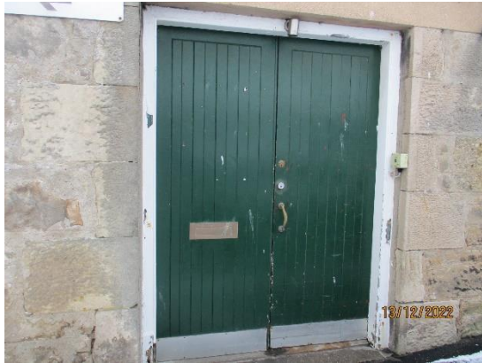
37. Timber TG&V doors
