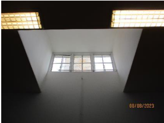
121. Metal "Crittall" windows
