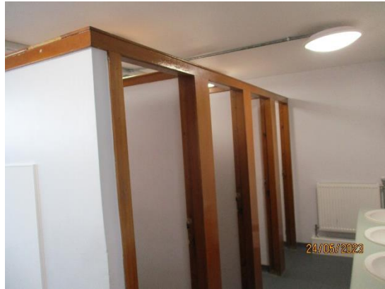
151. Stud wall cubicle partitions
