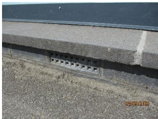
48. Underfloor/frame ventilation
