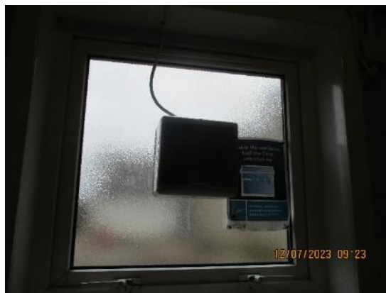
257. Extract fan boys toilet.
