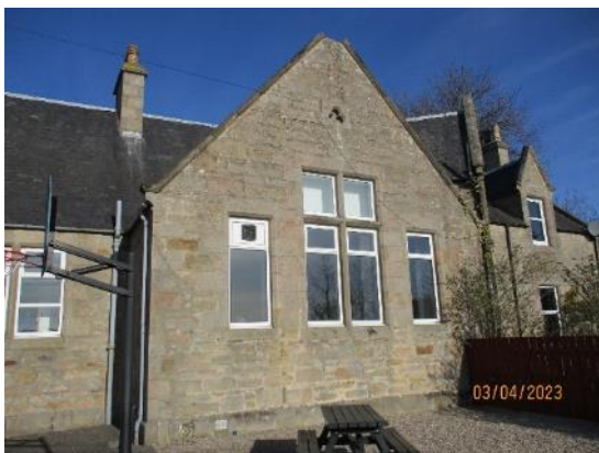
28. Natural stone walls
