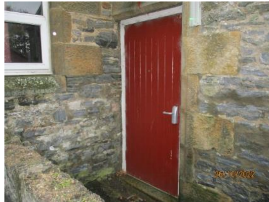
40. Timber fire escape door
